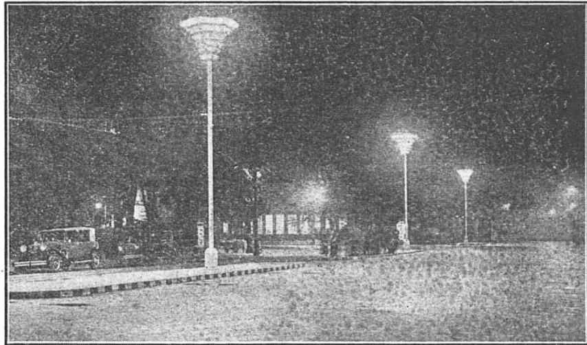
FIG. 5. — ÉCLAIRAGE D'UNE PLACE PUBLIQUE PAR TUBES LUMINESCENTS FONCTIONNANT SOUS BASSE TENSION A TRIESTE
