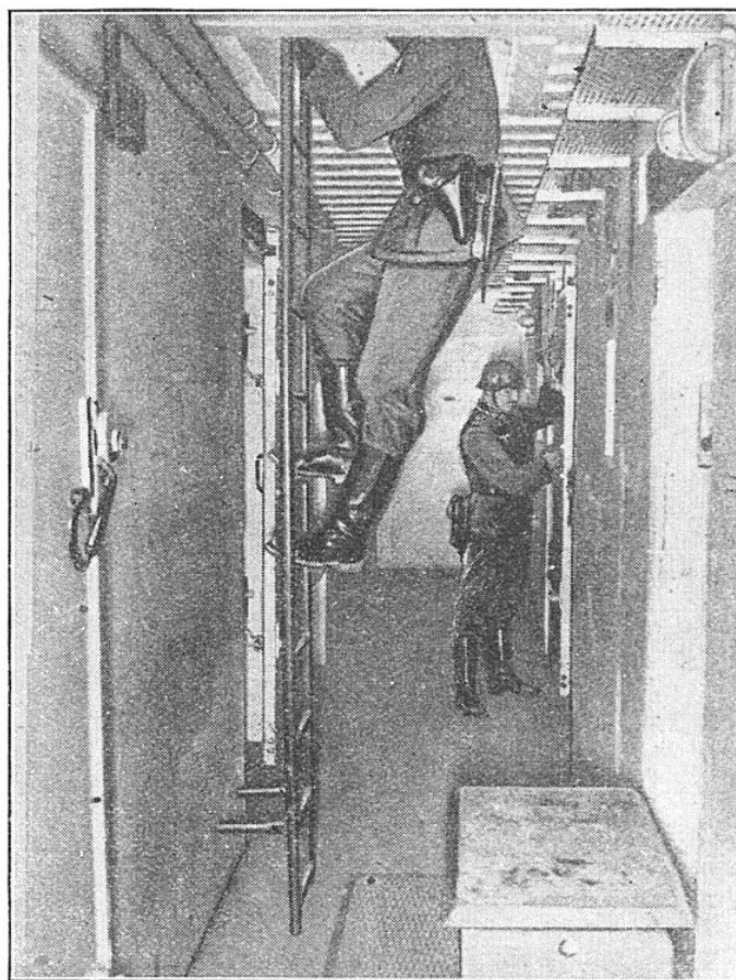
FIG. 10. — INTÉRIEUR D'UN BLOCKHAUS A DOUBLE ÉTAGE L'étage supérieur est réservé aux chambres de tir. L'étage inférieur constitue l'abri-repos d'une partie du personnel avec lits de camp, réserves de munitions et de vivres. Ces sortes d'abris sont plutôt rares sur la ligne Siegfried. Leur construction a surtout été poussée depuis septembre 1939 lorsqu'on s'aperçut que l'inconfort réagissait fortement sur le moral des occupants. Malgré ces améliorations, la vie est extrêmement pénible dans ces casemates.
