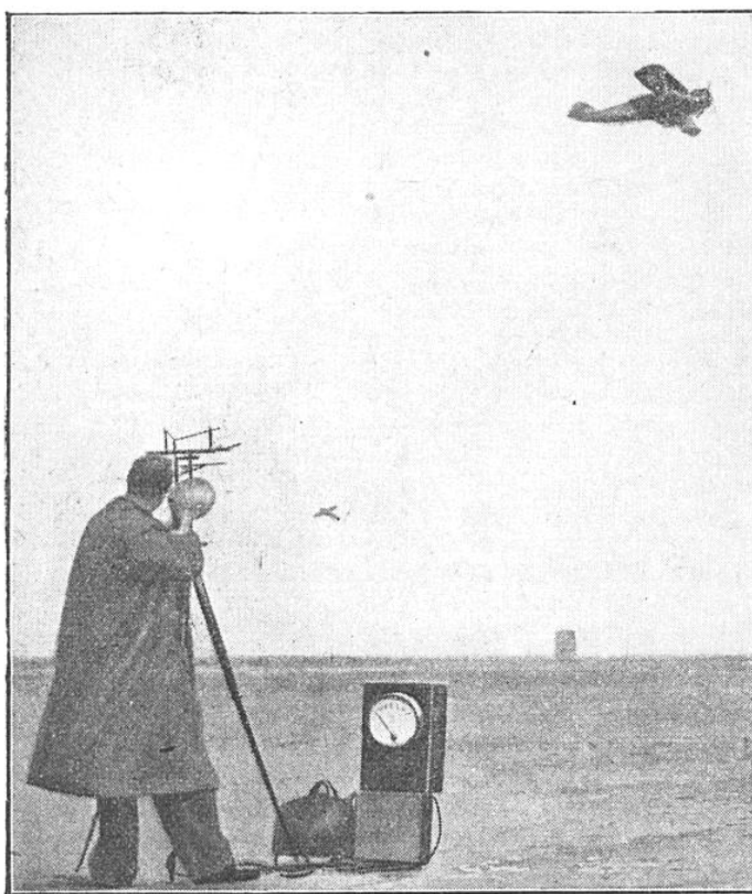
FIG. 11. — L'APPAREIL AMÉRICAIN « SENSYTROL » A ONDES ULTRACOURTES AURAIT PERMIS LA DÉTECTION DES AVIONS A UNE DISTANCE DE 14 KM
