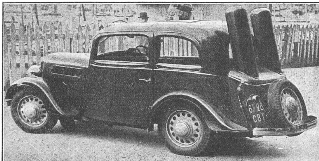
FIG. 6. — INSTALLATION DE BOUTEILLES D'ACÉTYLÈNE SUR UNE VOITURE 5 CH ROSENGART (M. HEYRAUD, A MARSEILLE)
