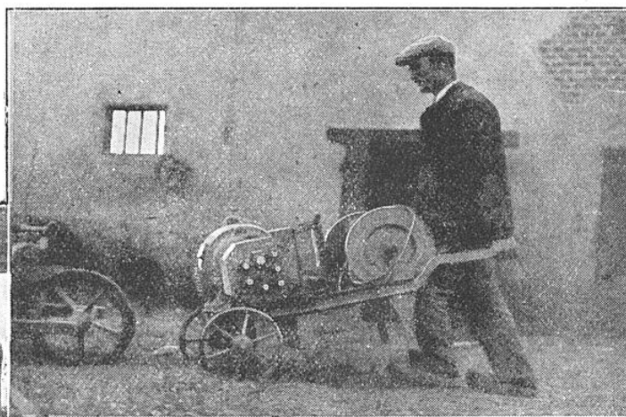
FIG. 7. — MOTEUR ÉLECTRIQUE DE 3 CH MONTÉ SUR BROUETTE ET CAPABLE D'ACTIONNER DES MACHINES AGRICOLES TRÈS DIVERSES
