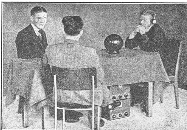
FIG. 6. — ENSEMBLE DE L'INSTALLATION POUR PERMETTRE A UN DEMI-SOURD DE SUIVRE UNE CONVERSATION
