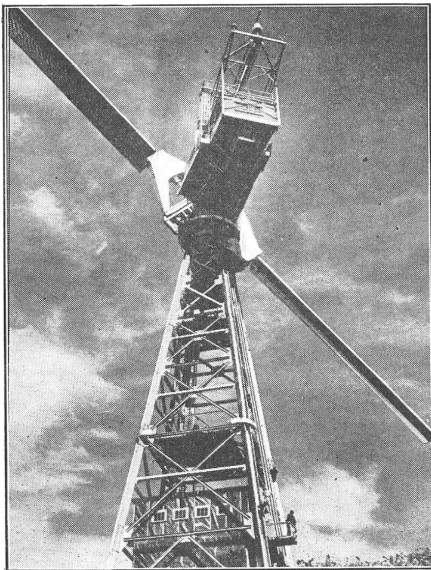
FIG. 5. — LA STATION ÉOLIENNE DE GRANDPA'S KNOB (E.-U.) DE 1 000 KW ACTUELLEMENT EN COURS D'ESSAIS
