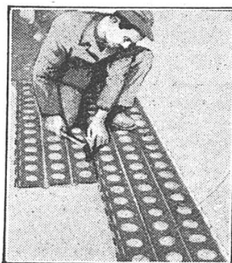
FIG. 3. — DÉTAIL DE L'AGRAFAGE DE DEUX BANDES
