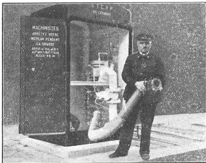
FIG. 10. — UN POSTE DE CHARGE DES RÉSERVOIRS À GAZ À LA PRESSION ATMOSPHÉRIQUE DES AUTOBUS PARISIENS T W 25148
