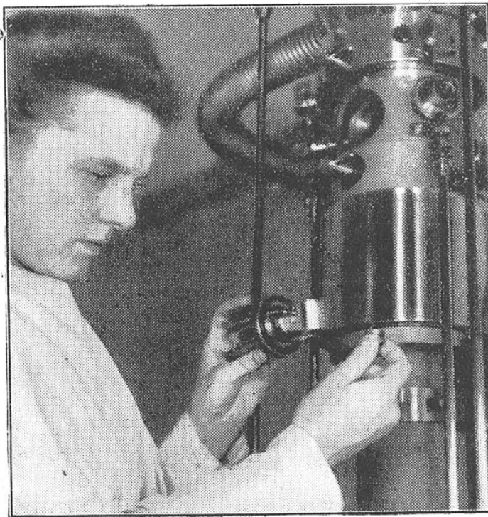
FIG. 4. — LA MISE EN PLACE DE LA SUBSTANCE A ÉTUDIER DANS LE PORTE-OBJET DU MICROSCOPE ÉLECTRONIQUE
