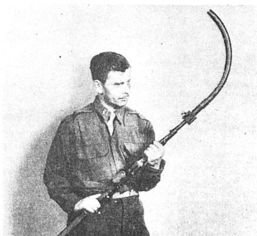
FIG. 13. — LE FUSIL COURBE ALLEMAND « POUR TIRER DANS LES COINS »
