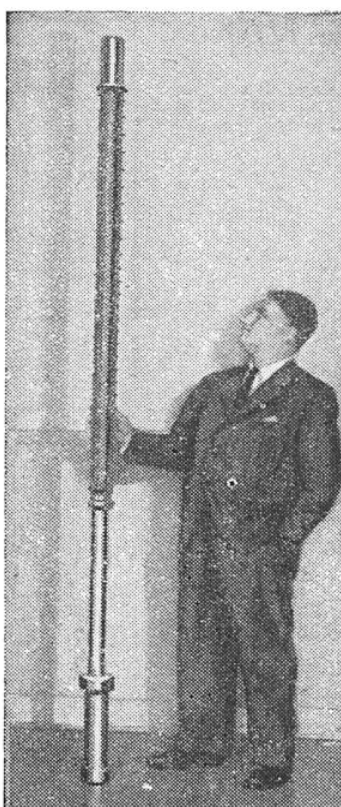
FIG. 1. — TUBE A RAYONS X DE 2 MILLIONS DE VOLTS
