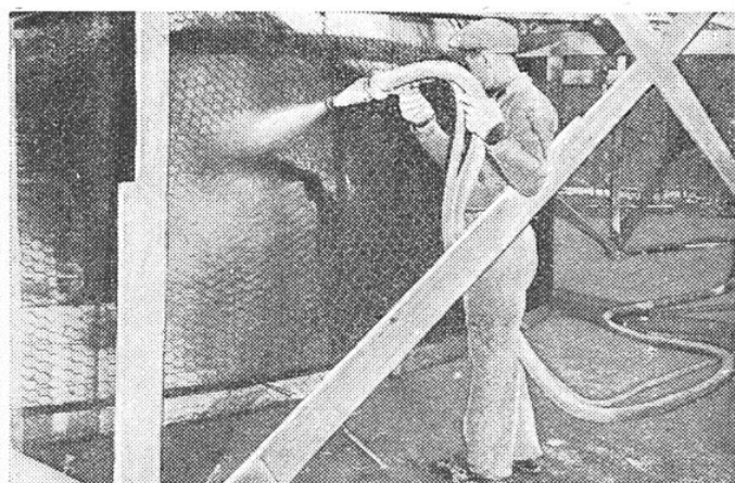
FIG. 1. — LA « MAISON BALLON » OU L'IGLOO EN CIMENT
